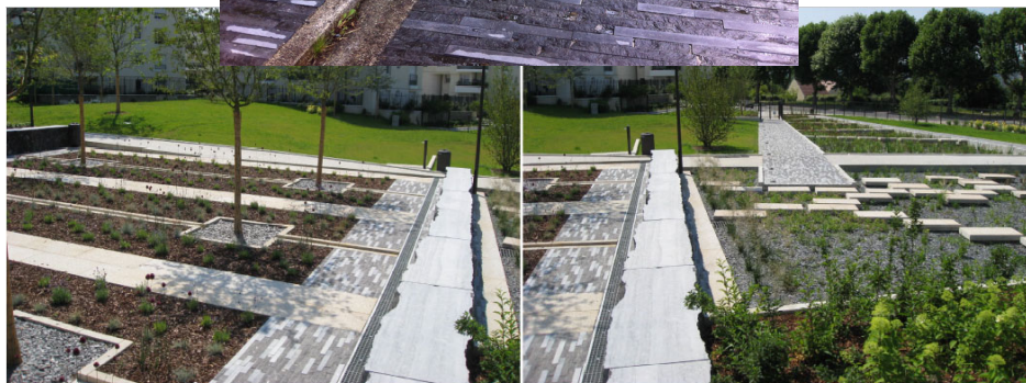
Les arbres ponctuels de la place sont irrigués naturellement par des rigoles au sol
