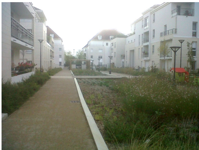
Exemple d'allées en stabilisés renforcés
