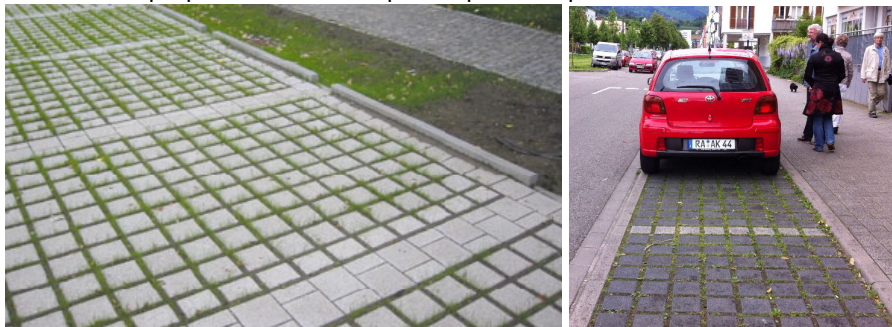
Exemples de parkings en pavés engazonnés
