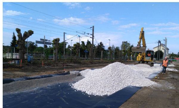
Mise en place de la rétention en structure réservoir sur le parking Nord
